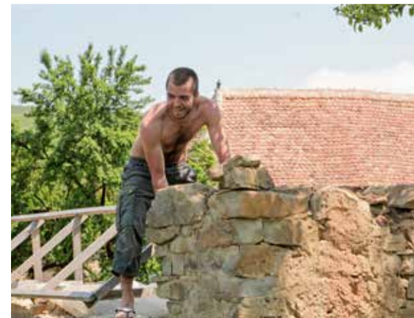
Omar hilft beim Mauern der alten Kirchenburg. Fotos: M. Götz
